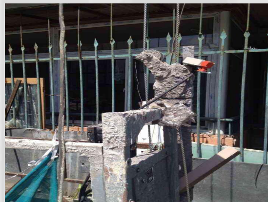
吊篮上行限位出发装置歪斜、失效、缺失，且安全锁开启手柄人为禁锢失效，安全锁铭牌缺失
