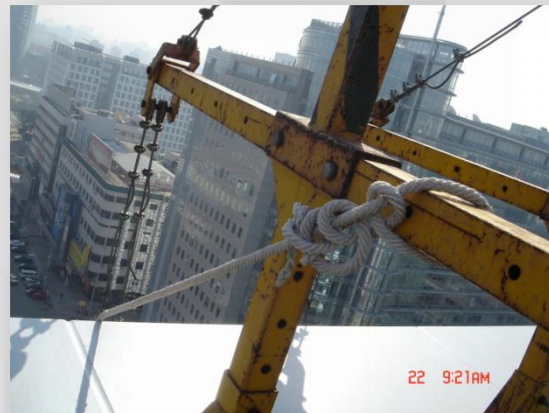
吊篮安全母绳固定在吊篮大臂上、安全母绳破损
