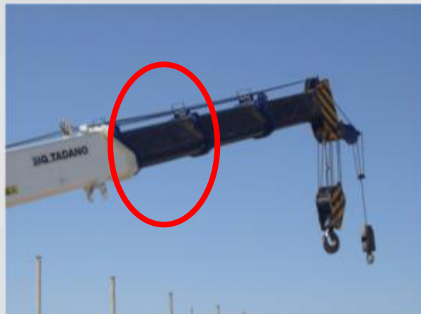
二级吊臂未完全伸出，未按使用要求逐级伸出
