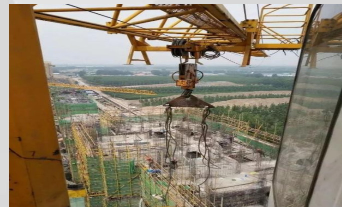
起升高度限位拆除，吊钩冲顶
