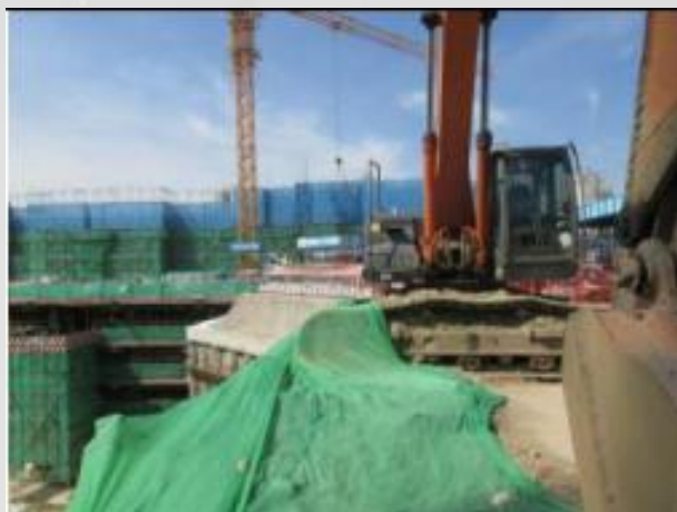
基坑顶部堆载已超设 计要求极限荷载值
