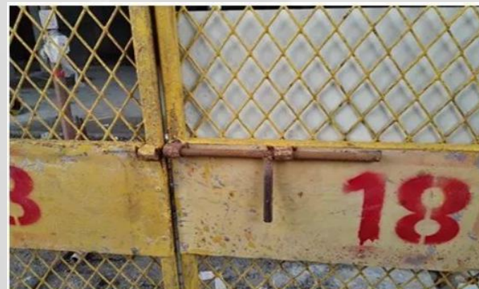
楼层停层平台防护门未安装，外侧平台防护门未上锁
