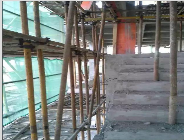
支模架用外脚手架作支撑与外脚手架相连
