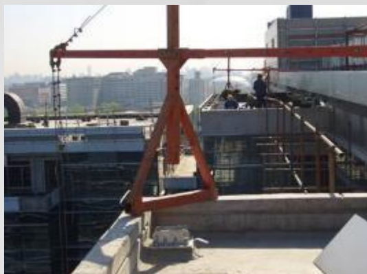
悬挂机构前支架支撑在 女儿墙上
