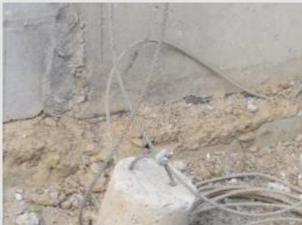
安全钢丝绳下端钢丝绳重 锤落地设置
