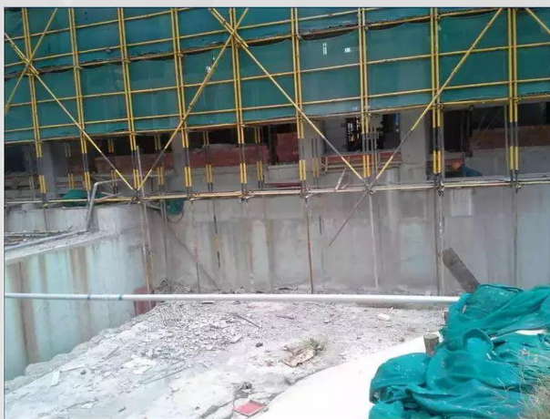
外脚手架剪刀撑不落地， 上部双立杆底部单立杆
