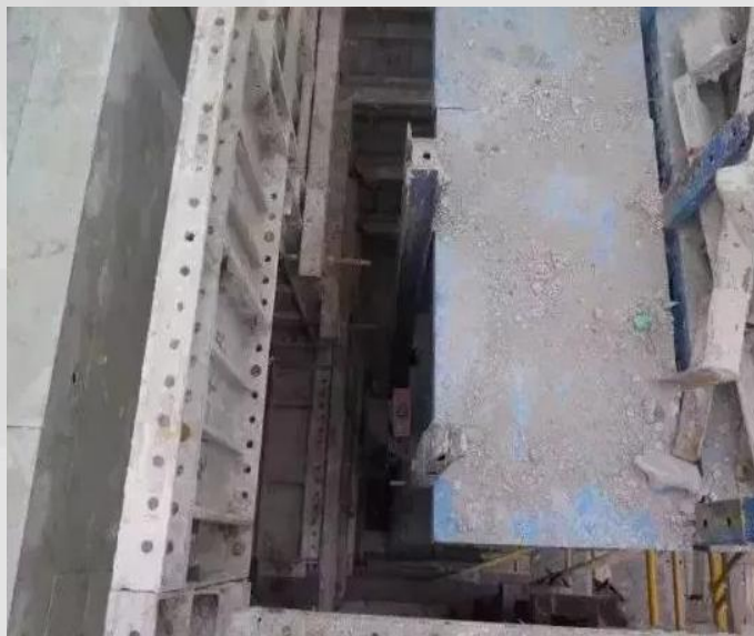
在提升过程中附着点缺失，导致上端悬臂过大出现主框架外翻
