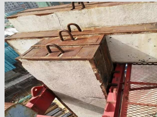
减少了配重块，空出的洞口未做防护，配重件未按要求设置
