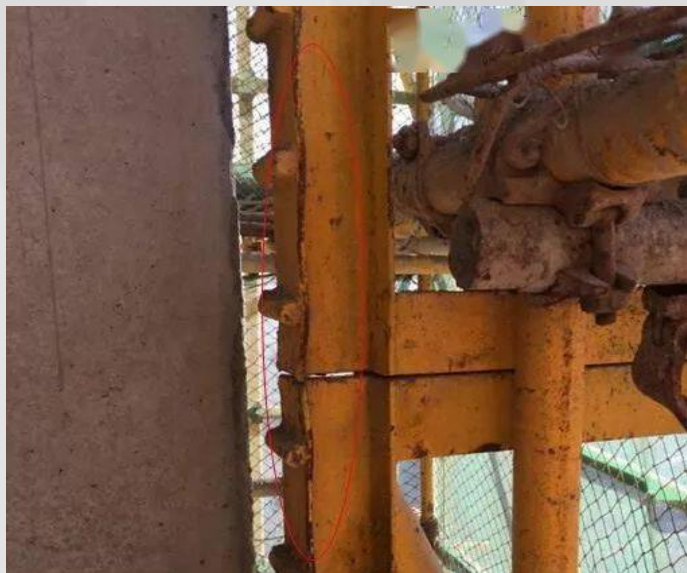
现场爬架主要受力构件及导轨存在明显变形
