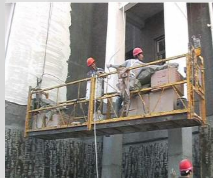
吊篮内垂直运输材料，荷载不满足要求
