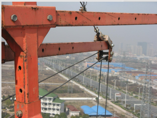
吊篮上行程限位挡块缺失且距悬挂点间距小于0.5m
