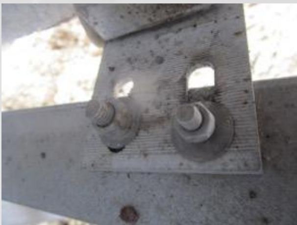
固定螺栓未按要求使用对应规格材料
