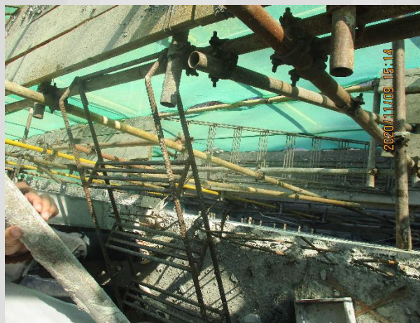
外架与结构间隙未设置安全兜网
