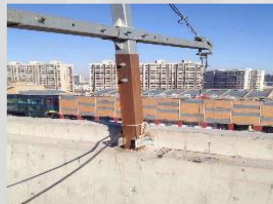
前支架直接搁置女儿墙上
