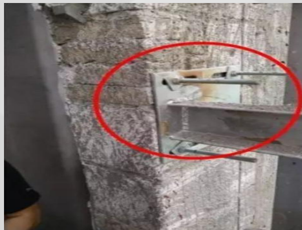
后补埋件固定于砖墙结处
