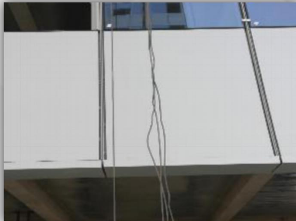
安全钢丝绳安全钢丝绳与 工作钢丝绳缠绕在一起
