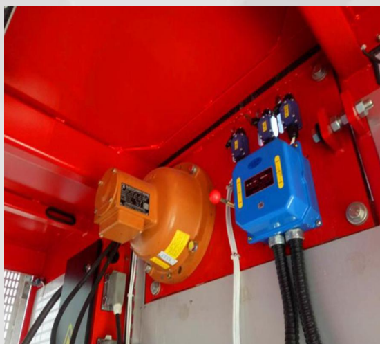
极限开关现场调试使用 未断电
