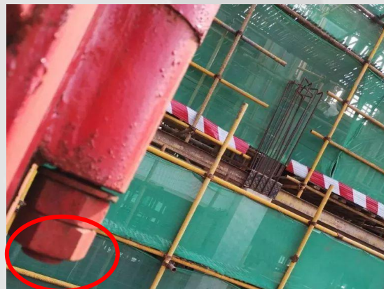
塔吊连接螺栓垫片缺失、安装松动，外露丝扣不足3P
