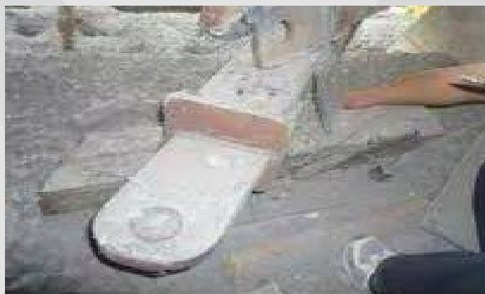
塔吊附墙与预埋板焊接连接
