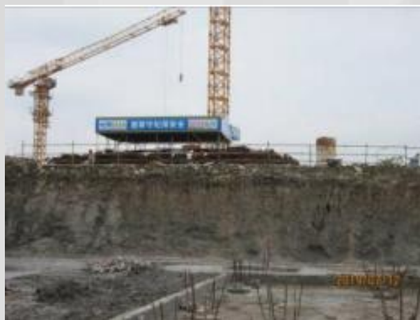
基坑顶部设置钢筋加工区
