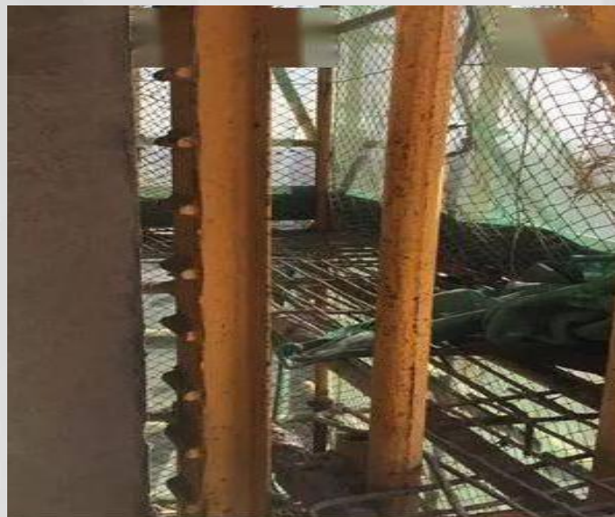
现场爬架主要受力构件及导轨存在明显变形
