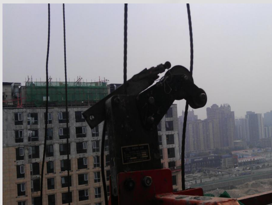
吊篮上行限位出发装置歪斜、失效、缺失，且安全锁开启手柄人为禁锢失效，安全锁铭牌缺失
