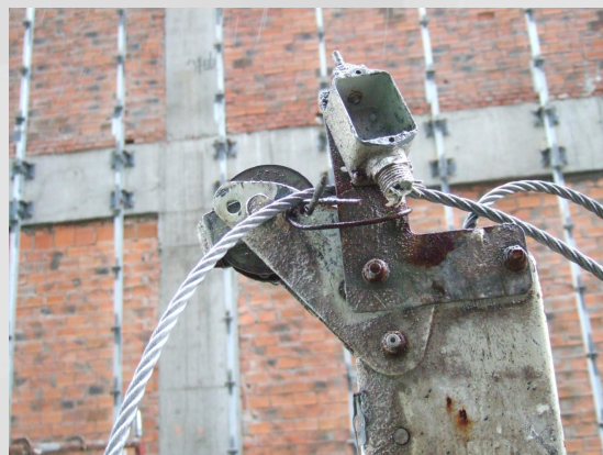
吊篮上行限位出发装置歪斜、失效、缺失，且安全锁开启手柄人为禁锢失效，安全锁铭牌缺失
