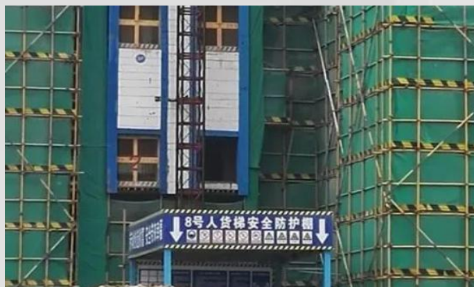
楼层停层平台防护门未安装，外侧平台防护门未上锁
