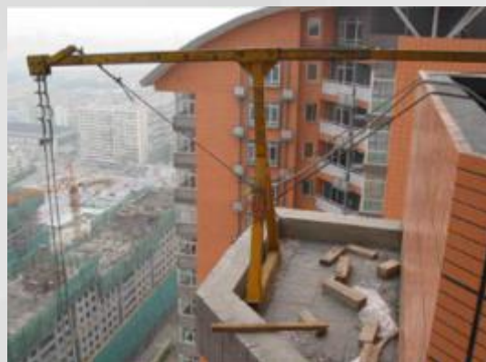
悬挂机构前支架支撑在 挑檐边缘
